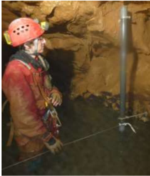
Figure 6 : installation d'un des puits de tranquillisation (photo Vincent Schneider).
